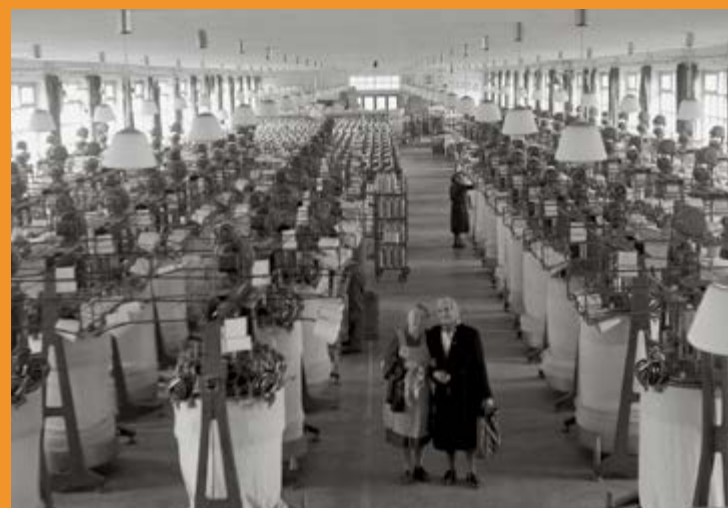
Hala pletárny s malopříměrovými francouzskými stávkami zn. Waga, které se používaly až do přelomu 70. a 80. let (1957).
