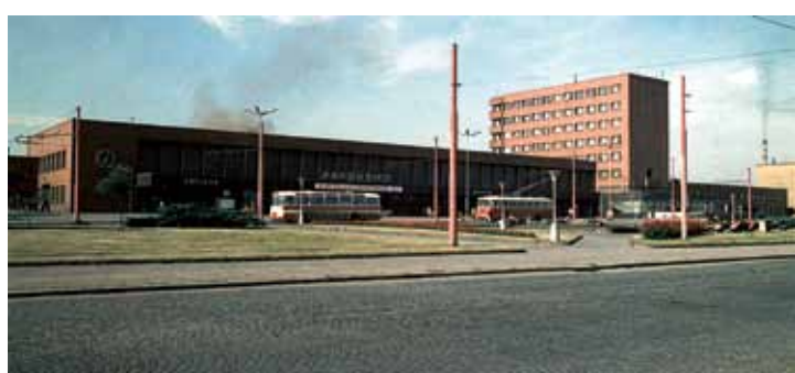
Nádraží v Pardubicích / der Bahnhof in Pardubitz (spolupráce / mit Karel Řepa), dokončeno / fertig gestellt 1958
